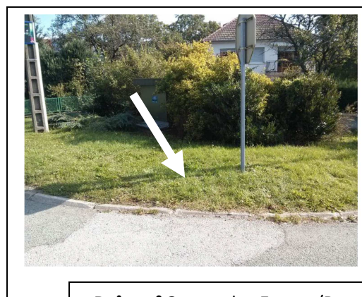
Boîte n° 3 : rue des Epreys/Route de Chaux
