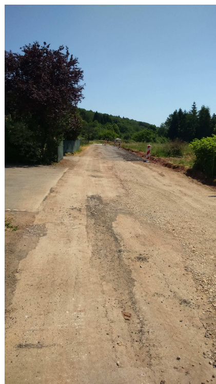
Création d'une voirie Accès zone du « Goussot »
